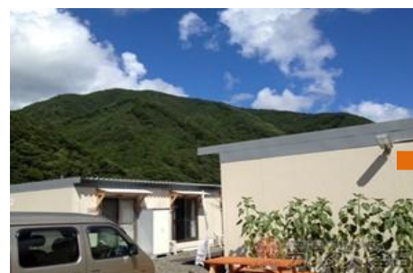
甲子町の大松仮設住宅団地
