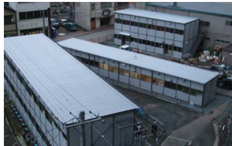
完成間近！南町仮設商店街！
