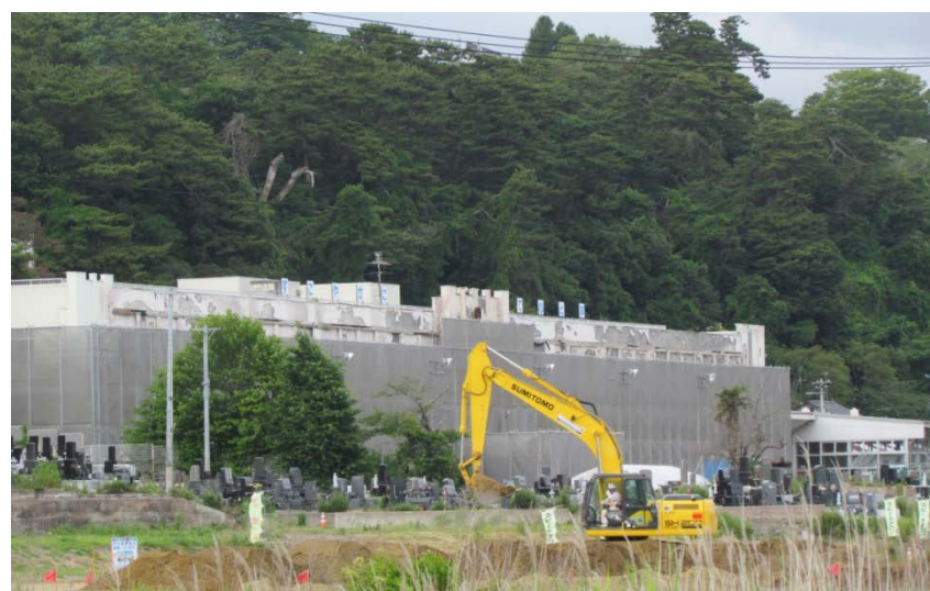
シートで覆われたままの旧門脇小学校（石巻市）
